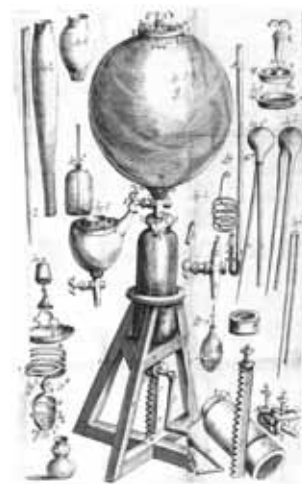
図5. ボイルの最初の空気ポンプ。『空気の弾力』(1600)の図版。
